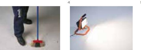
3 La superficie a revestir debe estar totalmente limpia de polvo o cualquier otra sustancia que pueda perjudicar la adhesión de las baldosas. Para colocaciones específicas (sistemas de calefacción radiante, fachadas con anclajes mecánicos, cerámica en techos o resolución de parámetros particulares de proyecto) solicitar información concreta adicional para cada situación.
