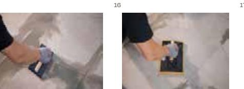
13 Respetar las recomendaciones del fabricante en la preparación y utilización de los materiales de junta. Comprobar que el material y herramienta elegida no dañan la superficie de la cerámica. El material de rejuntado se aplicará con llana de goma. En los catálogos de PORCELANOSA encontrarás el material de butech recomendado para cada modelo.
