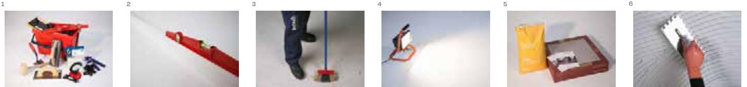
1 La colocación de cerámica requiere de personal cualificado, con experiencia demostrada y herramientas y útiles adecuados: llanas dentadas, crucetas, mazos de goma, ventosas para la colocación y llanas de goma, esponjas y cubetas para el rejuntable. Revisar previamente la información contenida en los embalajes y respetar escrupulosamente las recomendaciones del fabricante.
